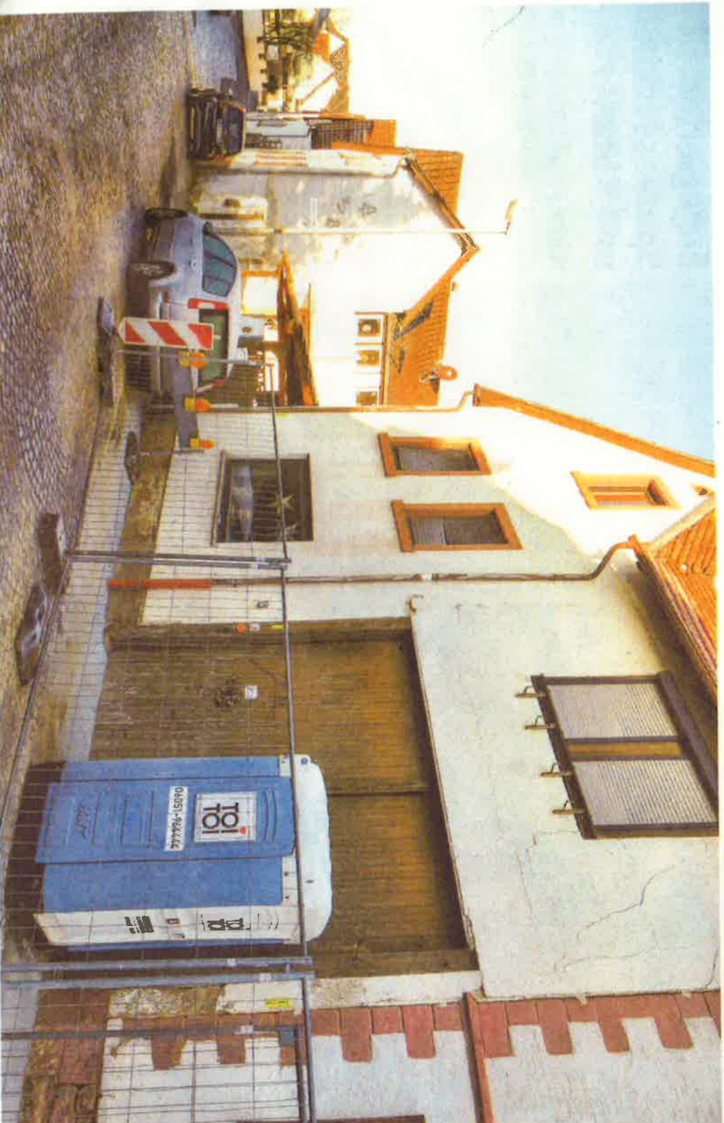
Wieder stabil: Ein Wasserrohrbruch hatte das Haus im Pfaffenhofener Dorfmauerweg im Januar 2016 beinahe zum Einsturz gebracht. Zunächst wurde der Keller mit Flüssigbo- den, inzwischen mit Beton gefüllt, und das Gebäude so gefestigt. Foto: Harald Schneider
