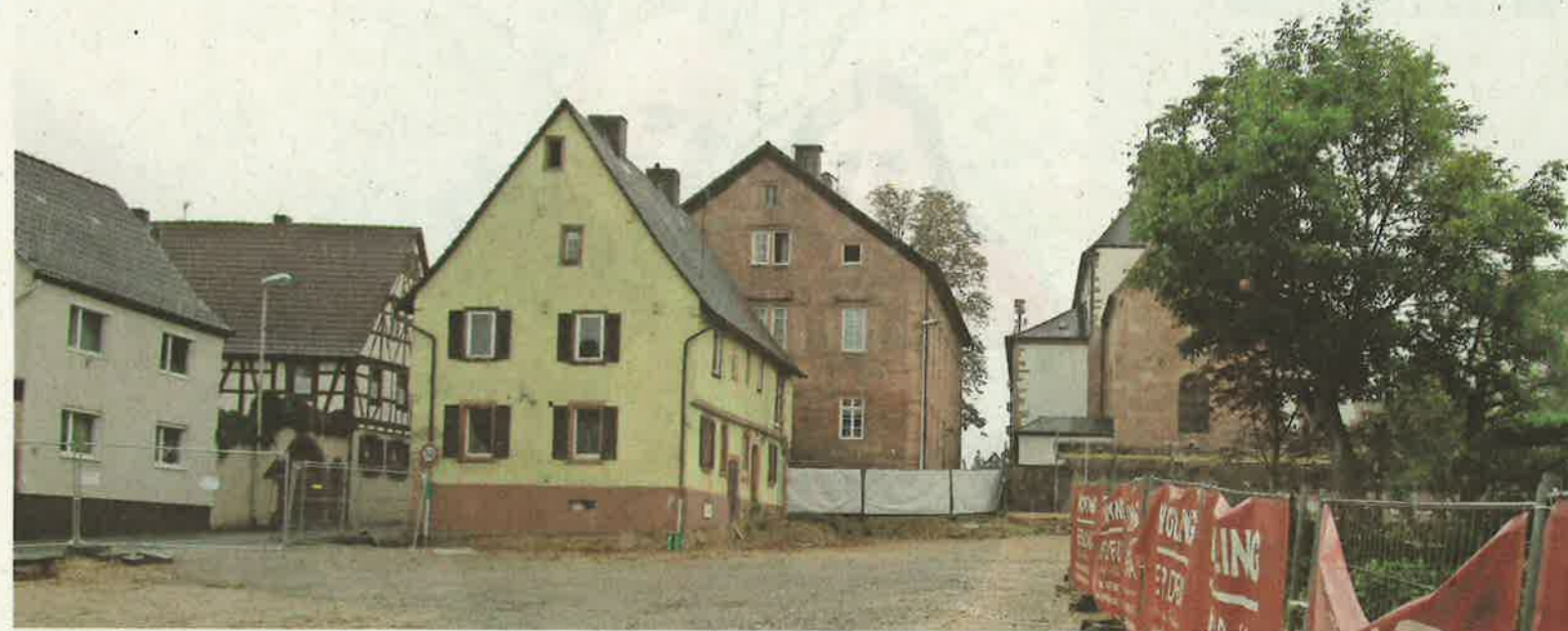
Hier entsteht ein Beratungszentrum: Beim Umbau des Benefiziatenhauses am Großostheimer Kirchberg soll das Fachwerk freigelegt werden.
